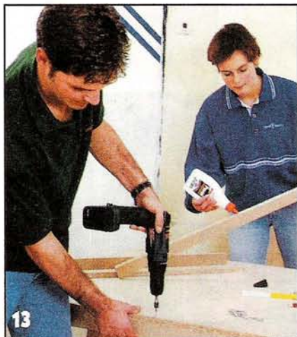
13 Вместо старого ограждения из двух досок возводят «стенку», завершающую лестницу. Для этого из ДСП делают короб, соединяя его детали на клею и шурупах.
