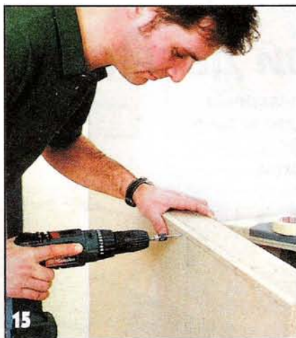
15 Обшив лицевую сторону короба, его оклеивают теми же обоями, что и перила лестницы.
