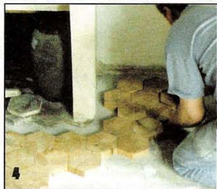
4 Пробелы по краям уложенных клёпок получают более или менее удобными для подгонки вставок.
