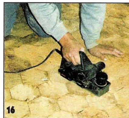
16 Выступающие клёпки простругивают рубанком заподлицо с остальной поверхностью.
