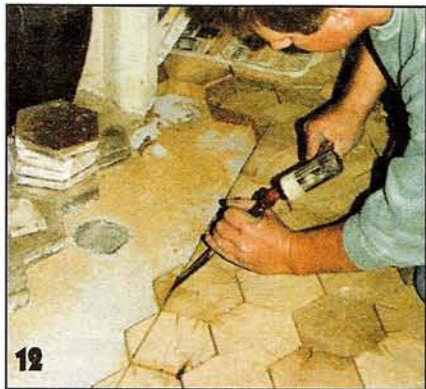
12 Поскольку пропилы получаются несквозными, углы окончательно отделяют стамеской.
