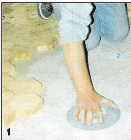
1 Поверхность затвердевшего выравнивающего раствора слегка зачищают грубой шлифовальной шкуркой и пылесосят.
