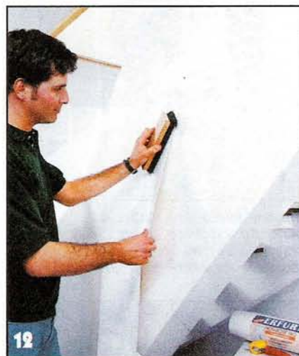
12 Обработав гипсокартонную обшивку грунтом, перила оклеивают тиснёными обоями с узорами под штукатурку.
