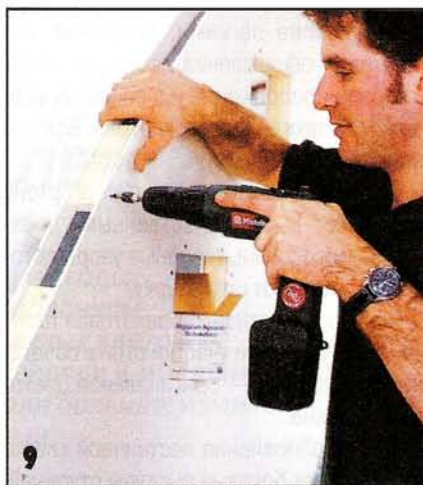
9 Обшивка примерно на 2,5 см выступает над старым поручнем, что позволяет уложить заподлицо с её элементами деревянные вставки для крепления гипсокартонной полосы (верхнего элемента обшивки), укрывающей зазор между листами боковой обшивки.
