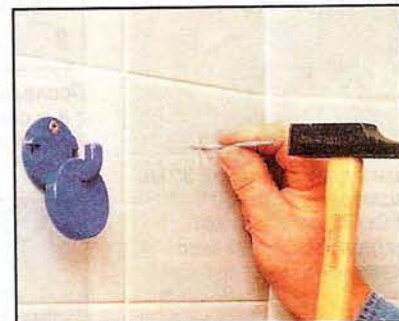
При сверлении отверстий в стенах, облицованных керамической плиткой, намеченную точку сначала необходимо осторожно накернить, пробив глазурованный слой, иначе сверло будет скользить по гладкой поверхности.
