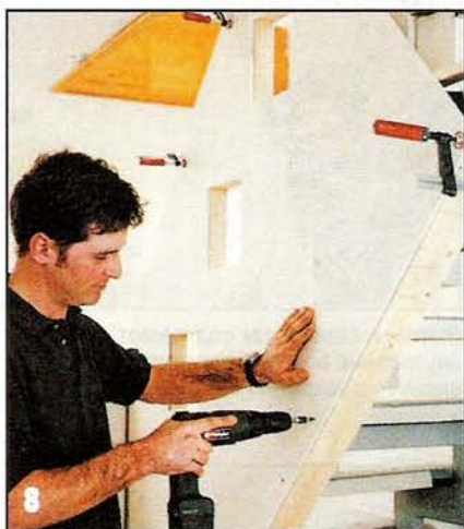
8 Теперь шурупами-саморезами с потайной головкой можно прикрепить наружный элемент обшивки.
