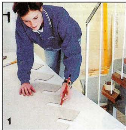
Прежде всего надо изготовить из картона шаблон, по которому из гипсокартона будут потом выкраивать боковые элементы обшивки.
