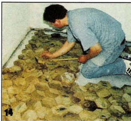
14 Вставки у стен кладут не сразу после укладки целых клёпок.
