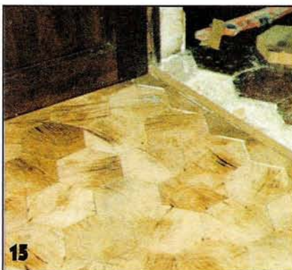
15 Так выглядит паркет у двери. Зазор между паркетом и дверной коробкой укрывают нащельником.
