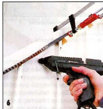
Опора для элемента обшивки — это отрезки деревянного бруска, прикреплённые на клее-расплаве к перилам.
