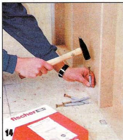
14 Собранный короб крепят к стене и полу.
