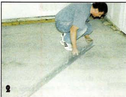
2 На полу прочерчивают базовые линии.
