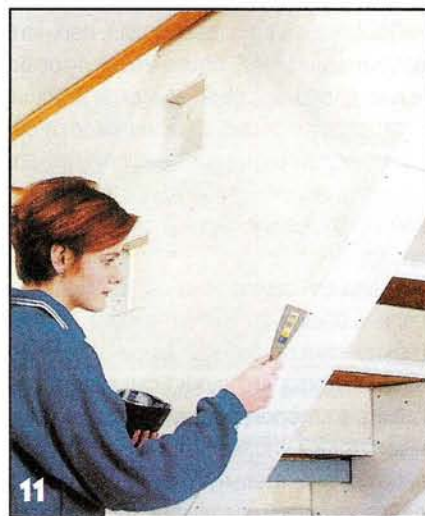
11 Стыки между элементами обшивки и лунки поверх головок шурупов аккуратно шпатлюют.
