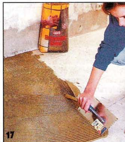
17 Плитка по плитке. Нанеся на основу клей и равномерно «прочесав» его зубчатым шпателем, сразу же кладут терракотовую плитку.
