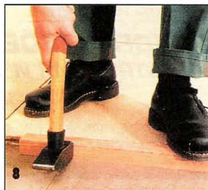
8 Проклеенные плиты сплавляют молотком через вспомогательный брусок, добиваясь полного смыкания швов.
