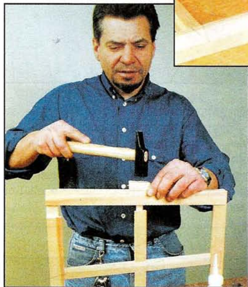
Горбыльки этой оконной рамы из древесины мягких пород соединены вполдерева, а детали обвязки рамы соединены на шипах. Всё склеивают за один приём.
