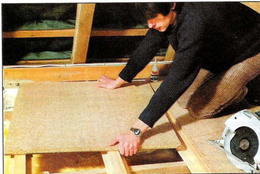
Плиты отлично подходят для устройства чёрного пола по лагам. Толщину их выбирают в зависимости от расстояния между лагами.
