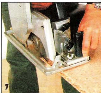
7 ДСП пилят ручной дисковой пилой или ножовкой. На торце, обращённом к стене, срезают гребень.
