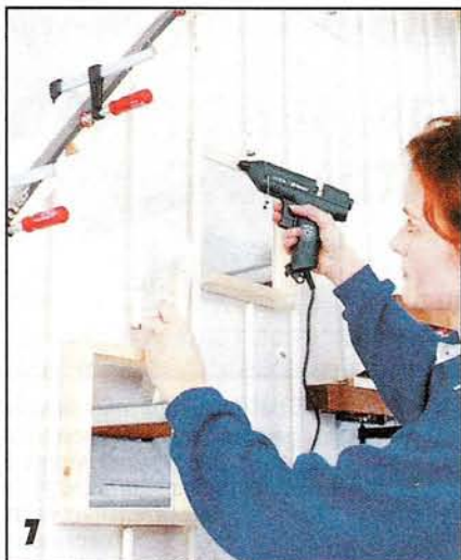
7 Квадратные окошки обрамляют также отрезками бруска, соединяемыми «на ус». Детали рамки фиксируют клеем-расплавом.
