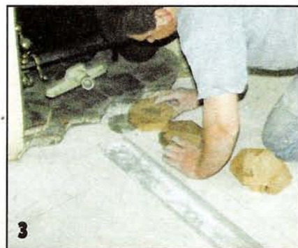
3 Прежде чем уложить паркет встык с керамическим покрытием пола у камина и за одним из его углов, клёпки сначала раскладывают всухую для пробы.
