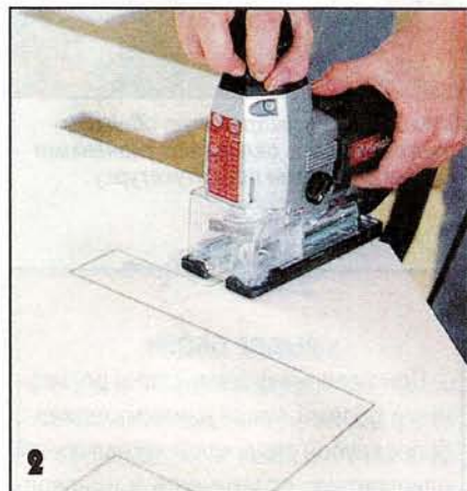
Нанеся с помощью шаблона контуры бокового элемента обшивки на гипсокартонный лист, выкраивают этот элемент электролобзиком с мелкозубой пилкой.
