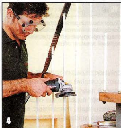
Части балясин перил, совпадающие с окошками, вырезают угловой шлифовальной машинкой.
