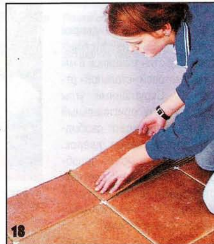
18 Дав клею затвердеть, по краям пола укладывают узкие резанные плитки.
