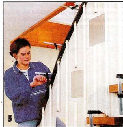
Здесь показано, как подгоняют внутренний боковой элемент обшивки, временно закрепив его струбцинами.
