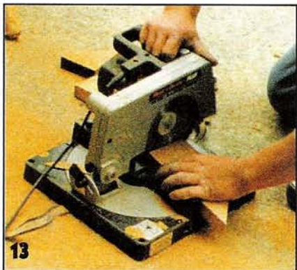
13 Затем доски обрешетки раскраивают по длине и зашлифовывают «на ус».
